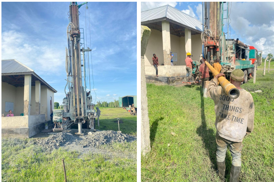
Het boren naar water op 120 meter diepte
